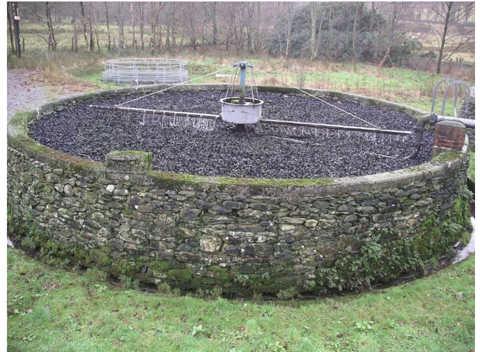
Damlatmalı Filtrenin Çalışma Prensibi
