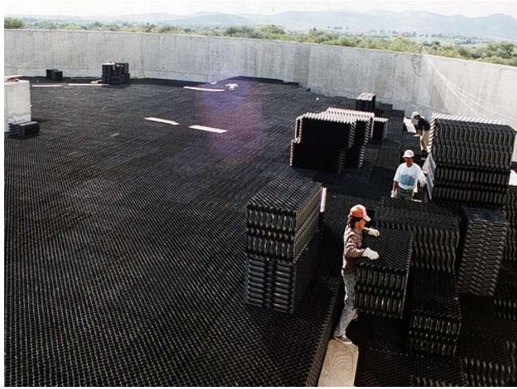
Plastik Dolgu Malzemesinin Yerleştirilmesi
