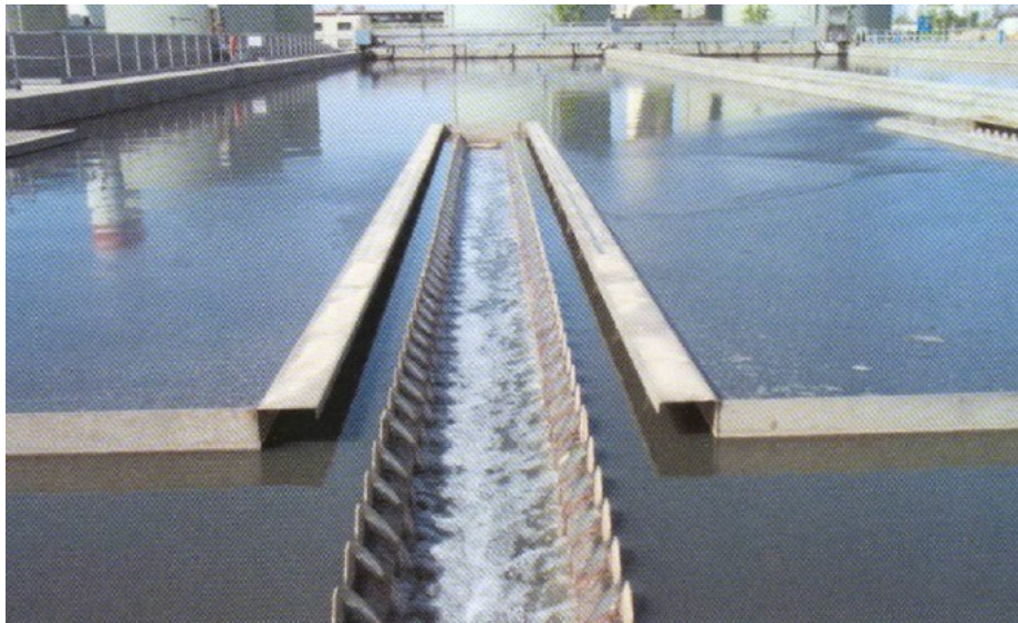
Şekil 12. Dikdörtgen ön çöktürme çıkış yapısı.
